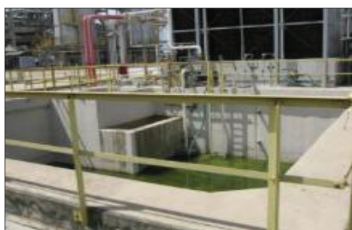
บ่อรวบรวมน้ำเสีย ES-1890 และระบบ Oil Skimmer
